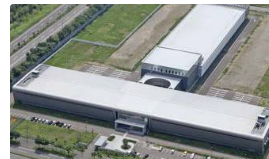
石狩データセンター4号棟予定地にコンテナ型データセンターを建設
