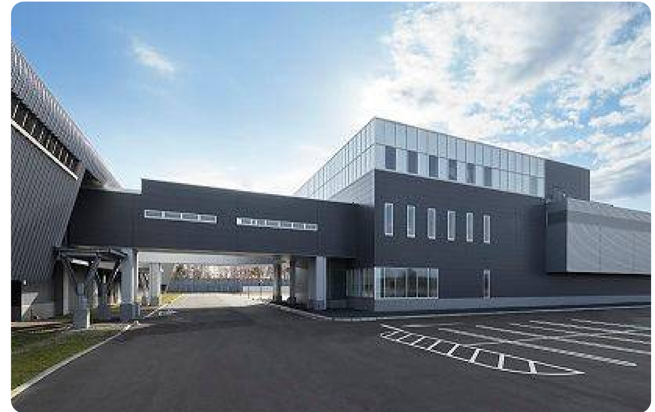
石狩データセンター3号棟
