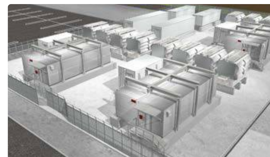
コンテナ型データセンター
